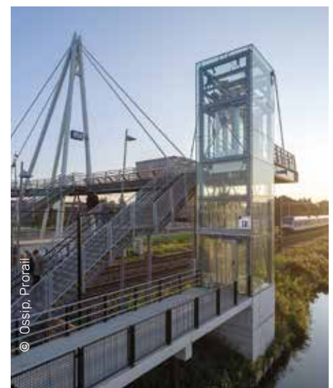
Uiterlijk 2030 moeten alle stations in Nederland zijn voorzien van een lift, zoals hier op Haarlem Spaarnwoude. Sinds de coronatijd hebben gemiddeld 10 tot 15 liften storingen die langer dan één week duren.
